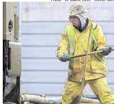
Deux équipes d'ouvriers se relaient sur le chantier chaque jour.
